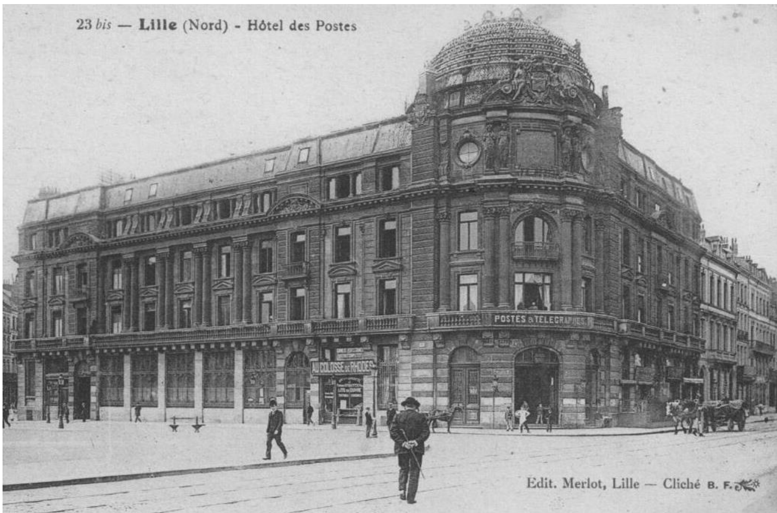
La station est installée dans les locaux de l'Hôtel des Postes
